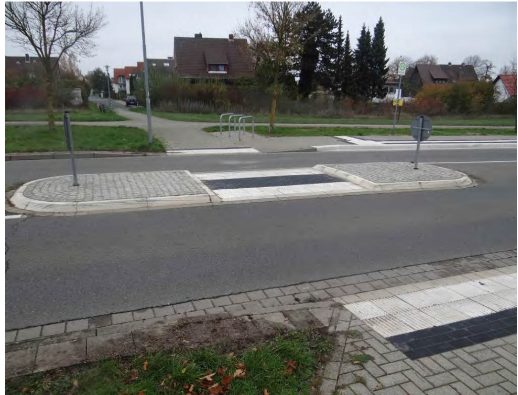
Mittelinsel in der Bruno-Kuhn-Straße mit durchgehender Nullabsenkung (ohne 6 cm Bord) und Blindenleitsystem
