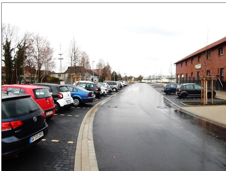
Abbildung 4-23: Parkfläche am Bahnhof Gifhorn Stadt
