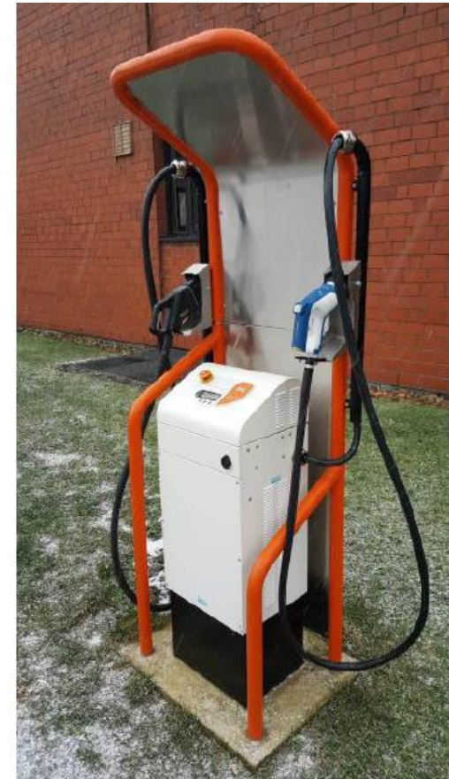
Schnellladesäule mit CCS, Typ2, Chademo 50 – 350 kW
