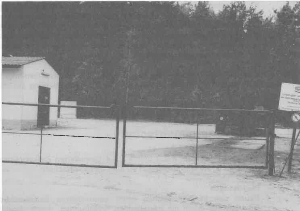
Betriebsgelände südwestlich von Emmen mit mehreren Quadratmeter großem ölverschmutzten Boden
