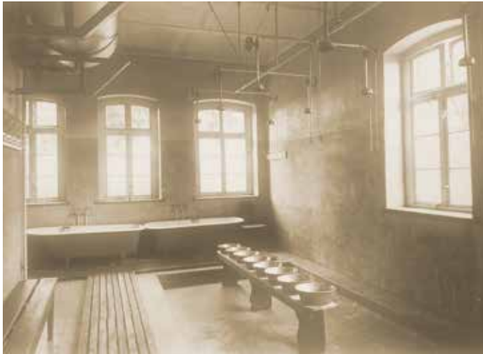
Abb. 14: Waschraum in der Arbeiterkolonie um 1931
