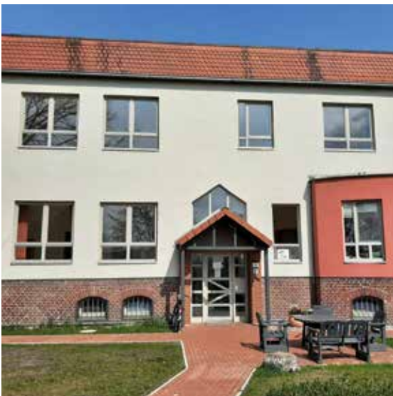
Abb. 54: Das Erziehungsheim Rischborn wurde 1966/67 umgebaut. Das Haus ist bis heute Teil der Kästorfer Jugendhilfe
