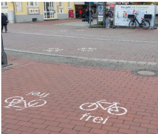
Abb. 50: Piktogrammketten leiten den Radverkehr in der geöffneten Fußgängerzone, Quelle: BÖREGIO 2021
