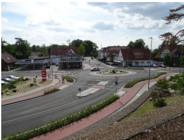
Abb. 33: Kreisverkehr am Katzenberg (Calberlaher Damm) in Gifhorn, BÖREGIO 2021
