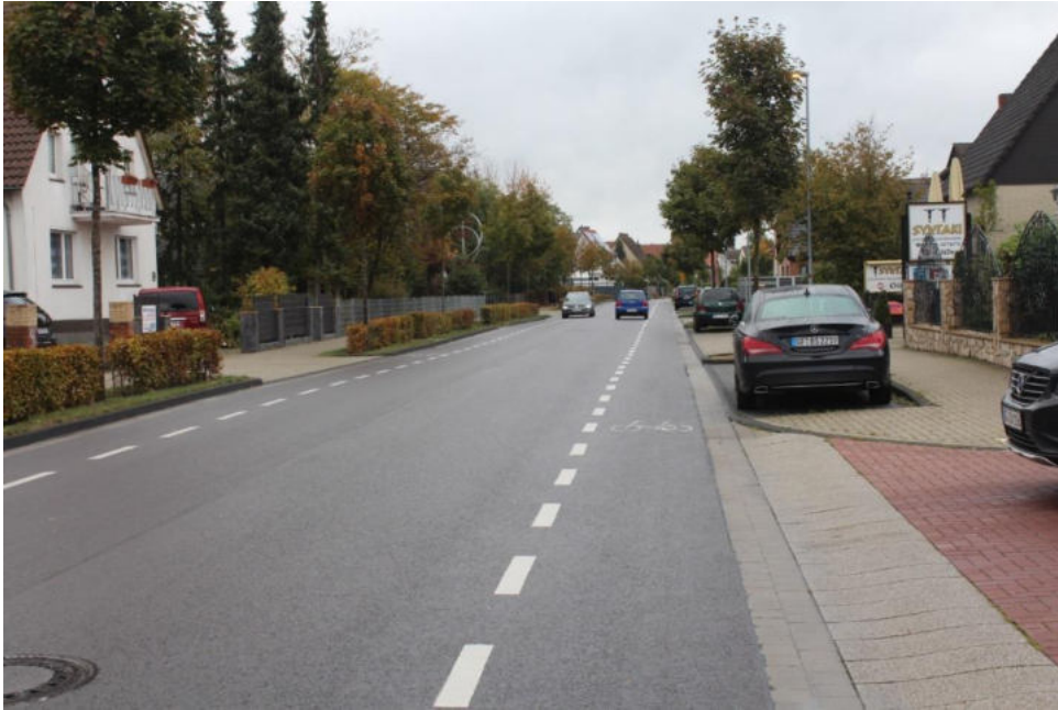
Abb. 30: Schutzstreifen auf der Straße "Alter Postweg", BÖREGIO 2021
