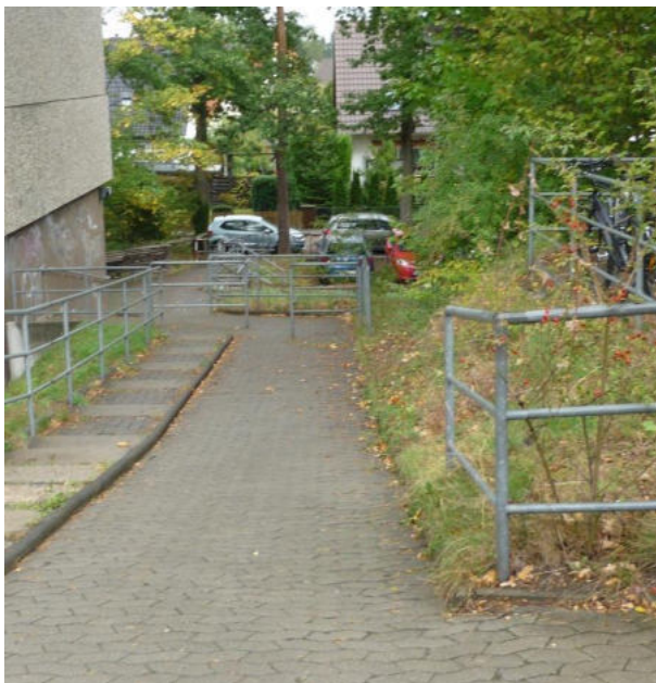
Abb. 15: Mit Umlaufsperrern hinderlich gestaltete Zuwegung am Otto-Hahn-Gymnasium, Quelle: BÖREGIO 2021
