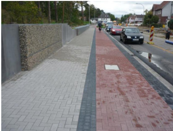
Abb. 25: Einrichtungsradschwergewicht am Calberlaher Damm mit 1,60 Breite, BÖREGIO 2021
